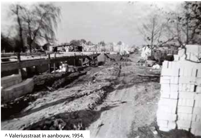
^ Valeriusstraat in aanbouw, 1954.
